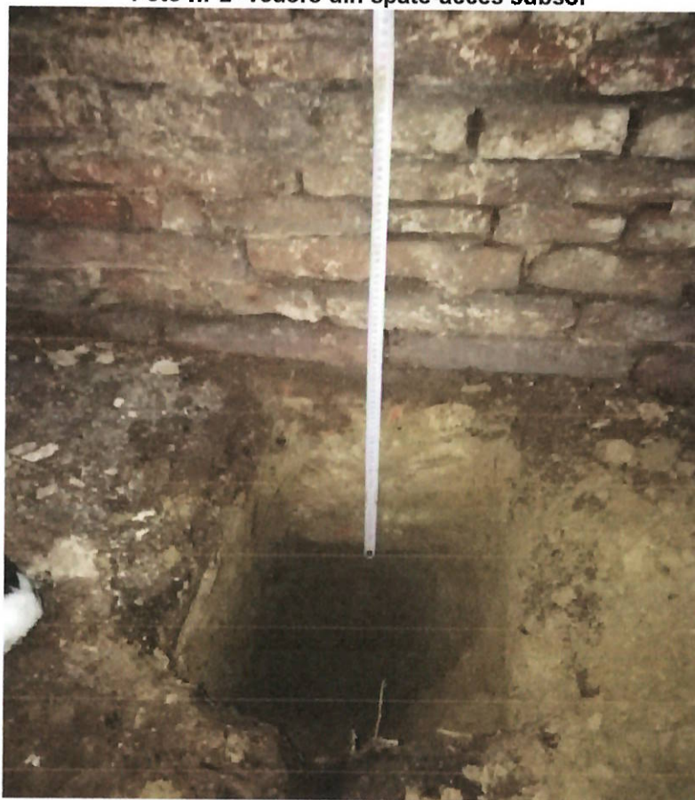
Foto nr. 3- dezvelire la fundația subsolului
